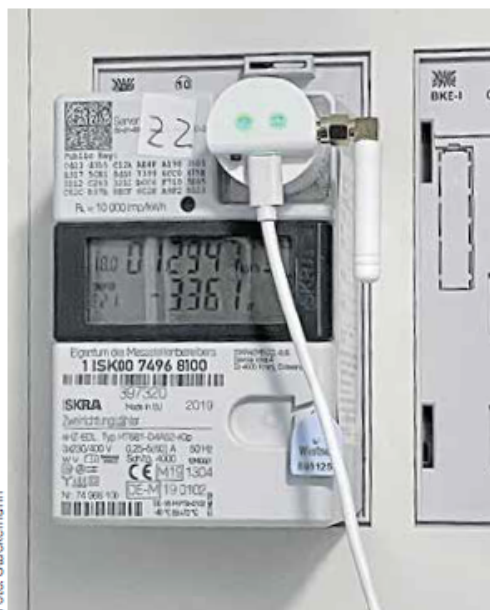
Damit Energy Sharing funktioniert, müssen Daten fließen. Bei der Stromcommunity der EEG H-S hilft zum Beispiel der abgebildete Lesekopf.
